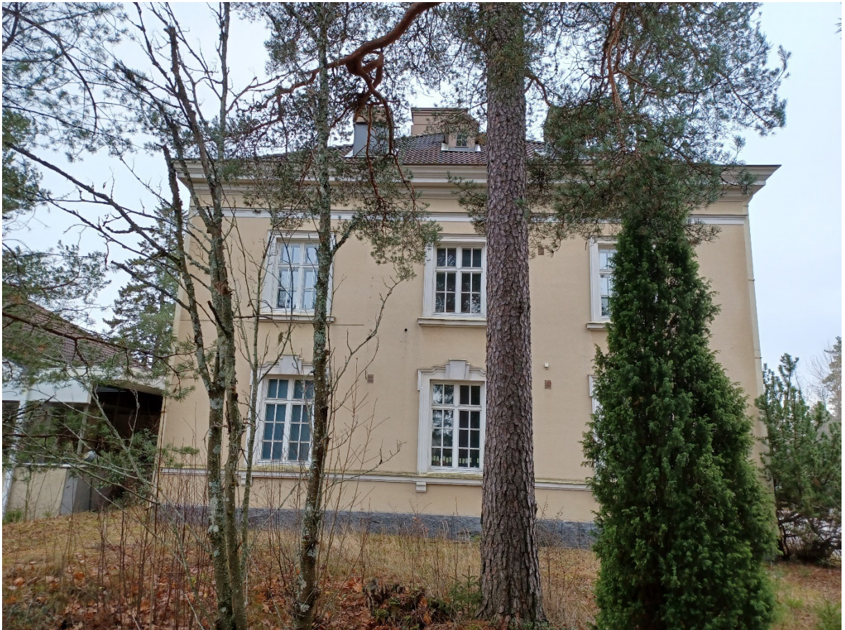
Kuva 38 Pohjoispuolen julkisivu. Ensimmäisen kerroksen ikkunat ovat 16-ruutuiset ja yläkerran 12-ruutuiset.
