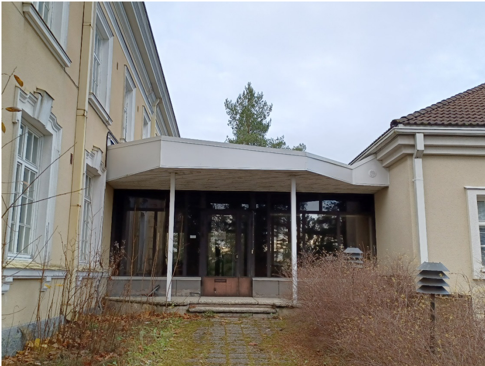
Kuva 81 Väliosa, joka yhdistää vanhan rakennuksen (kuvassa vasemmalla) laajennukseen (oikealla).
