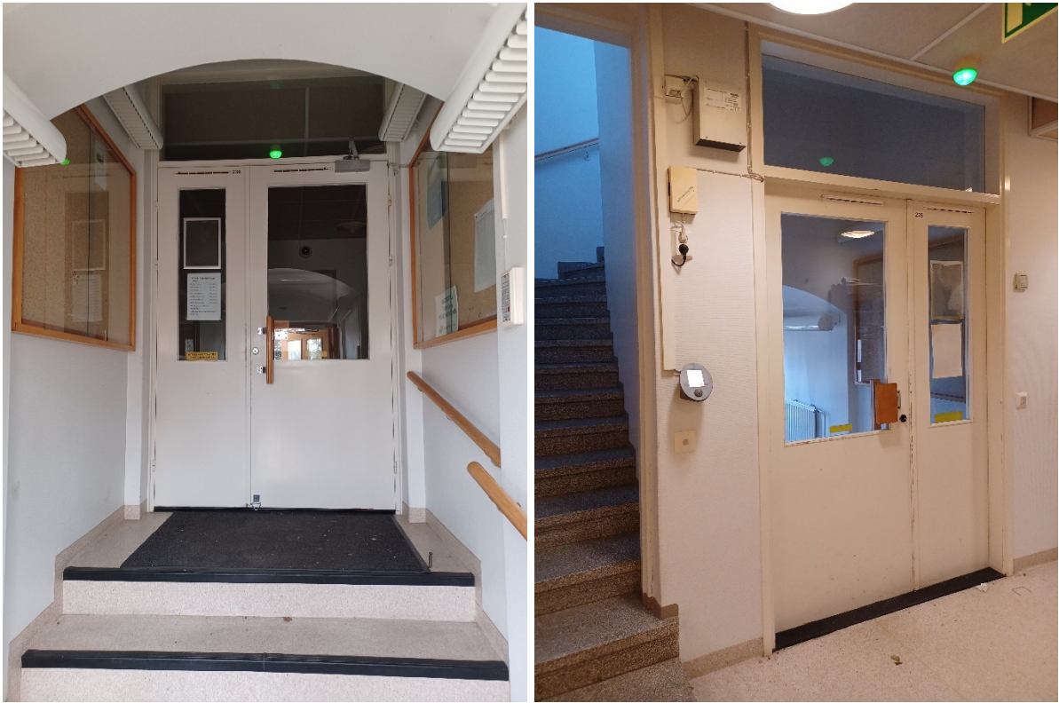
Kuva 43 Pääsisääkäynnin kaikki pintamateriaalit, valaisimet ja ovet on uusittu. Portaikon holvattu katto-muoto on kuitenkin alkuperäinen.
