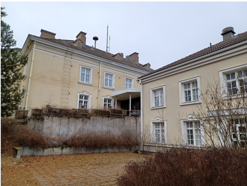
Kuva 82 rakennusten välillä on suurin piirtein yhden kerroksen verran korkeuseroa. Pihojen välillä on betoninen seinämä, jolla on pensasistutuksia. Seinämän päällä kulkee moniosainen, metalli- ja lasirakenteinen kaide.
