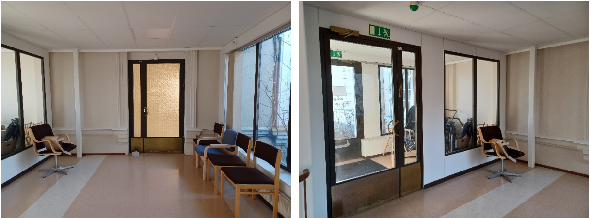
Kuva 87 Yksi vanhan osan ikkunoista on laajennettu sisäänkäynniksi yhdysosaan. Oikeanpuoleisessa kuvassa on yhdysosan tuulikaappi ja sisäänkäynti.
