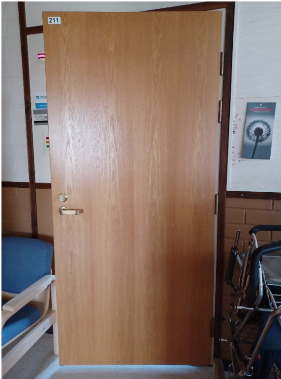
Kuva 92 Ovet ovat puisia laakaovia.
