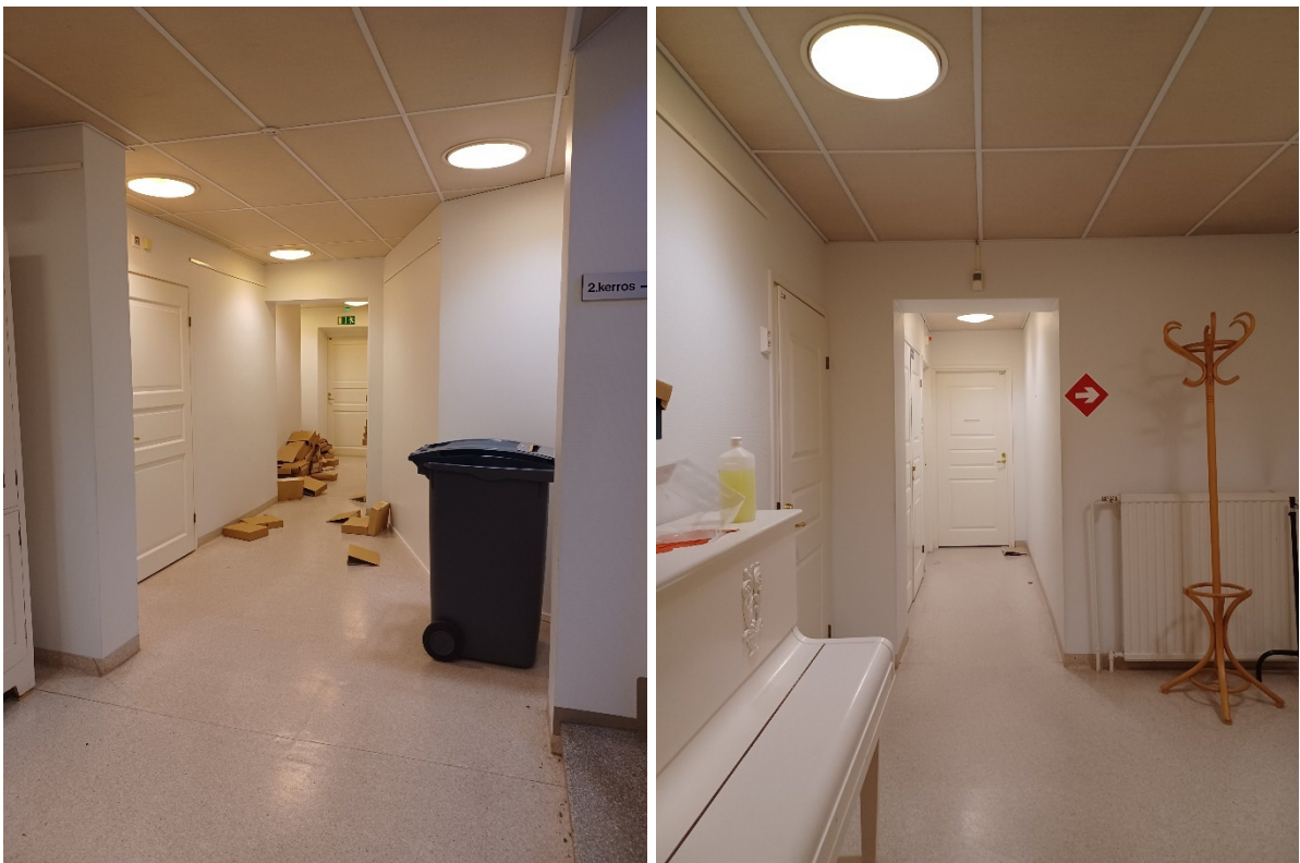
Kuva 44 1. kerroksen aulan pintamateriaalit, ovet ja muut detaljit, kuten valaisimet, on uusittu. Myös seinien paikkoja on muutettu.
