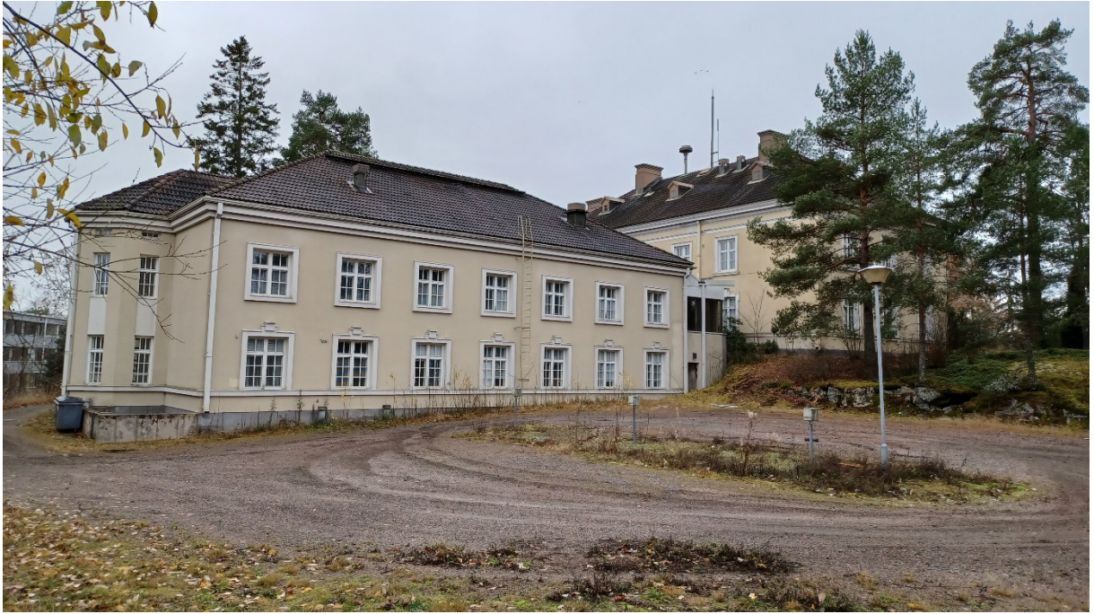
Kuva 79 Julkisivu pohjoiseen ja paikoitusalue.
