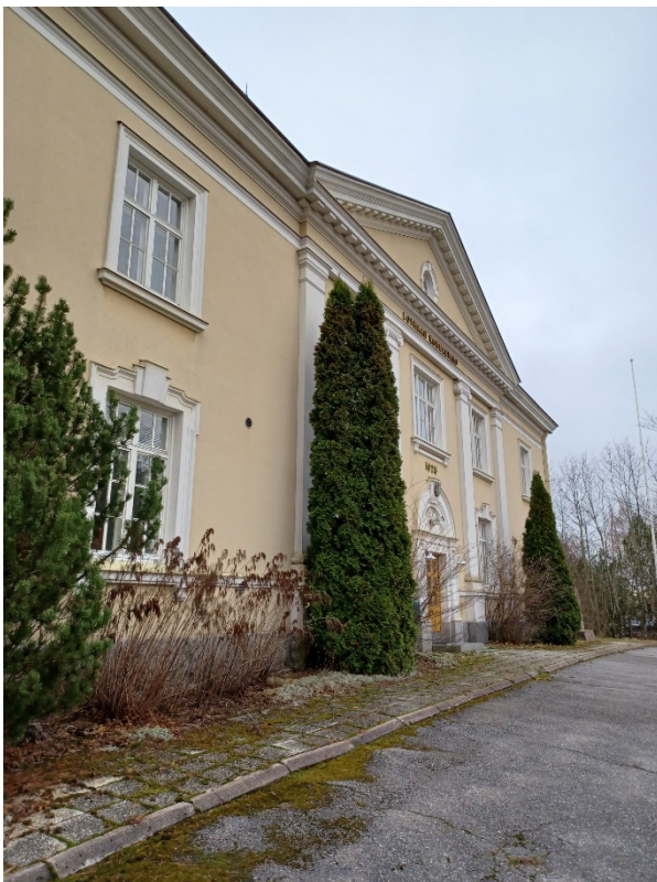
Kuva 39 Rakennuksen pääjulkisivua lännen puolella.
