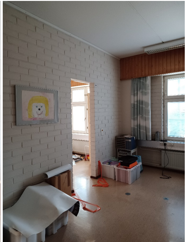
Kuva 89 Toimistuhuoneet ovat toistensa kaltaisia. Seinät ovat vaaleaksi maalattua tiiltä. Katot ovat roiskerapatut. Lattioissa on vaaleat muovimatot. Valaisimet ovat loisteputkivalaisimia. Ikkunan yläpuolella on yksityiskohtana mäntypanelointi. Osassa toimistotiloista on kulku viereiseen huoneeseen.
