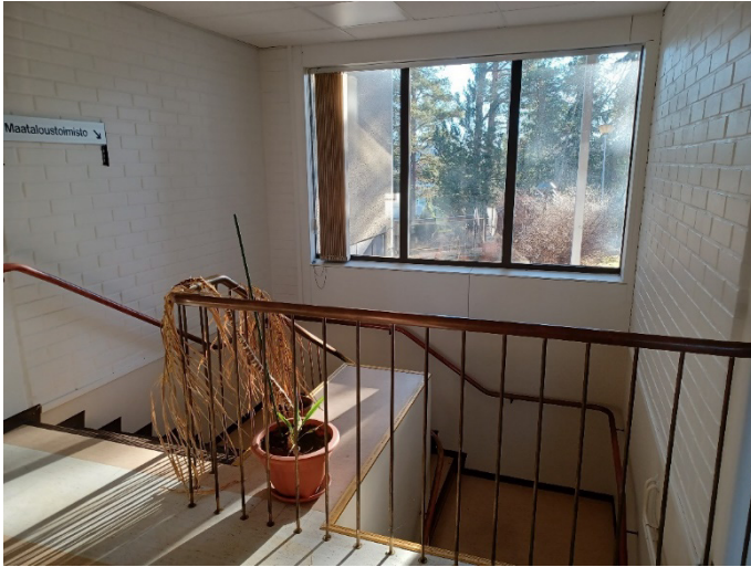
Kuva 88 Yhdysosasta johtaa portaikko alakertaan. Pinnakaiteet ovat messinkiset.
