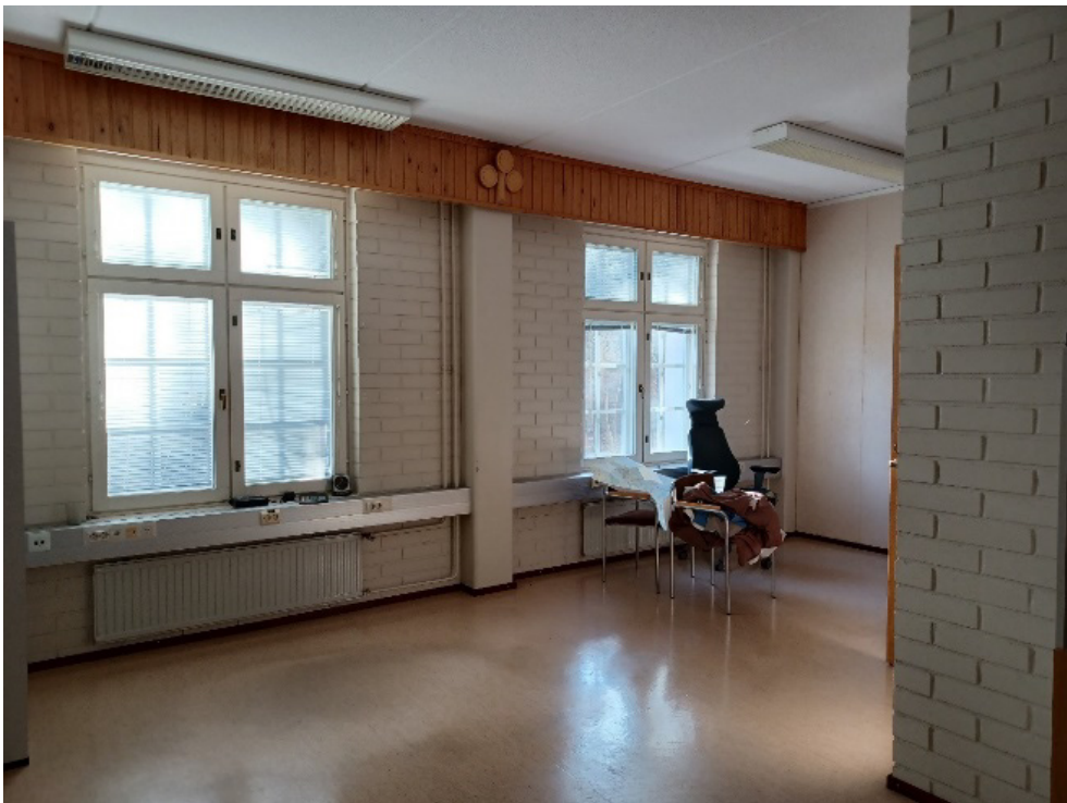
Kuva 95 Suurempi tila, joka ilmeisesti on toiminut kokoushuoneena.
