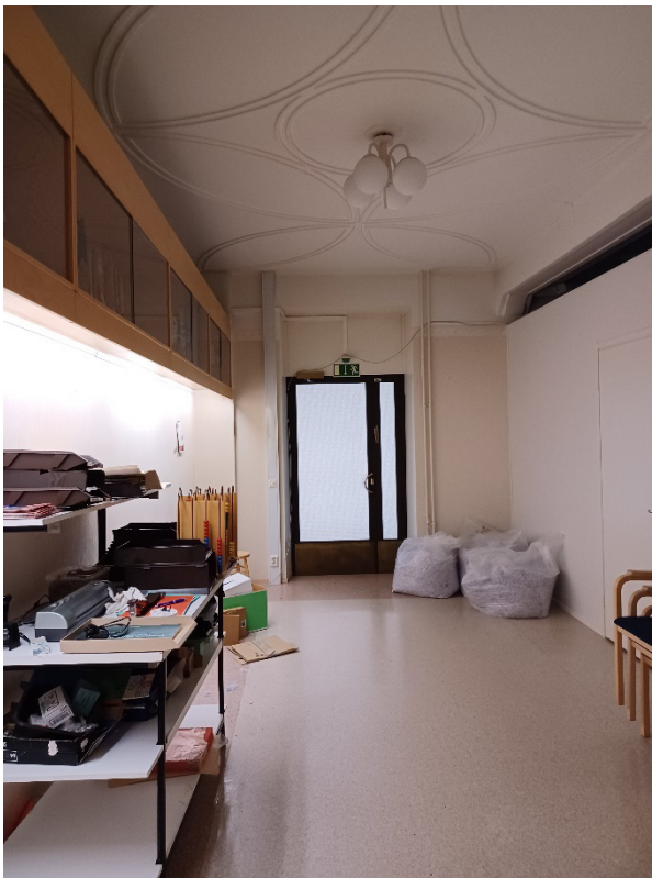
Kuva 46 Katon koristemuodot ovat edelleen jäljellä. Kuviot ovat todennäköisesti olleet moniväriset. Valaisimet eivät ole alkuperäiset. Lasiovesta on kulku väliosaan ja sen kautta laajennukseen.
