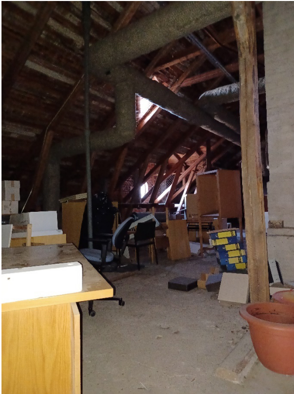
Kuva 64 Ullakko on eristämätöntä, avointa tilaa, jossa vanhat kattorakenteet ja uudemman aikaiset ilmaputkistot ovat vapaasti näkyvissä.
