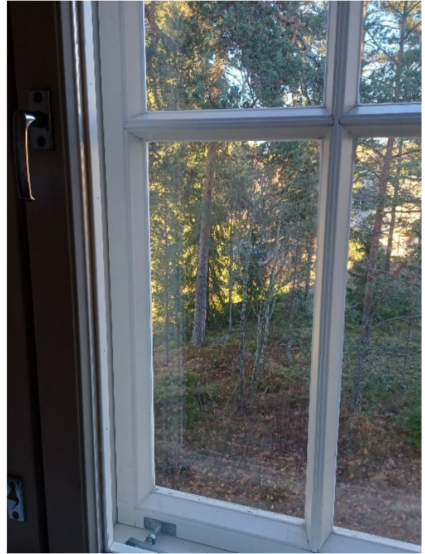
Kuva 63 Toisen kerroksen sisäikkunoita. Ikkunanpielen maalipinta on rapistunut todennäköisesti liiallisen kosteudenvaihtelun vuoksi.
