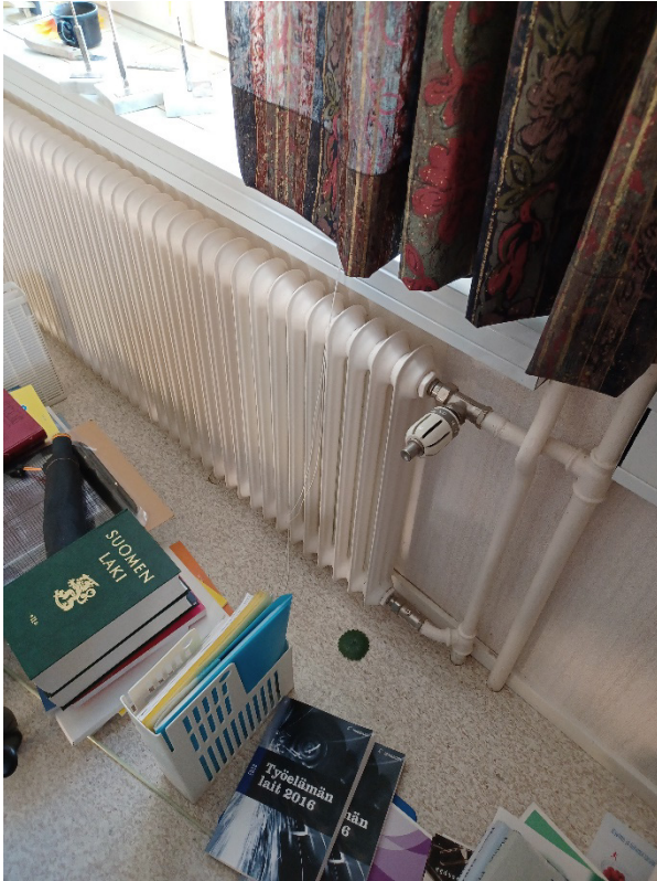
Kuva 52 Osaan huoneista on jätetty vanhat valurautapatterit.
