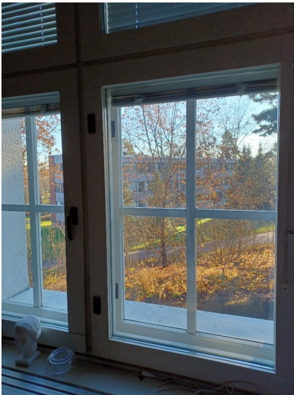
Kuva 91 Sisäikkunat ovat yksiruutuiset ja puu-alumiinirakenteiset.
