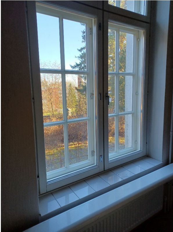
Kuva 49 Sisäikkunat ovat yksilasiset puu-alumiini-ikkunat.
