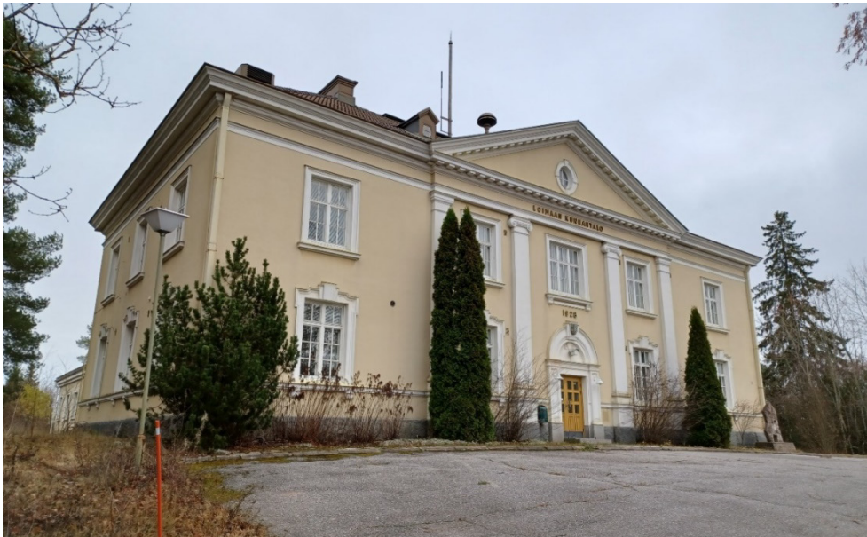
Kuva 35 Pääsisäänkäynti sijaitsee rakennuksen keskiosassa, jossa päätykolmiota "kannattelevat" joonialaiset pilasterit. Koristeaiheet ovat mukaellisia antiikin kreikkalaisesta arkkitehtuurista, ja niitä on käytetty 1920-luvun klassismin aikakaudella.
