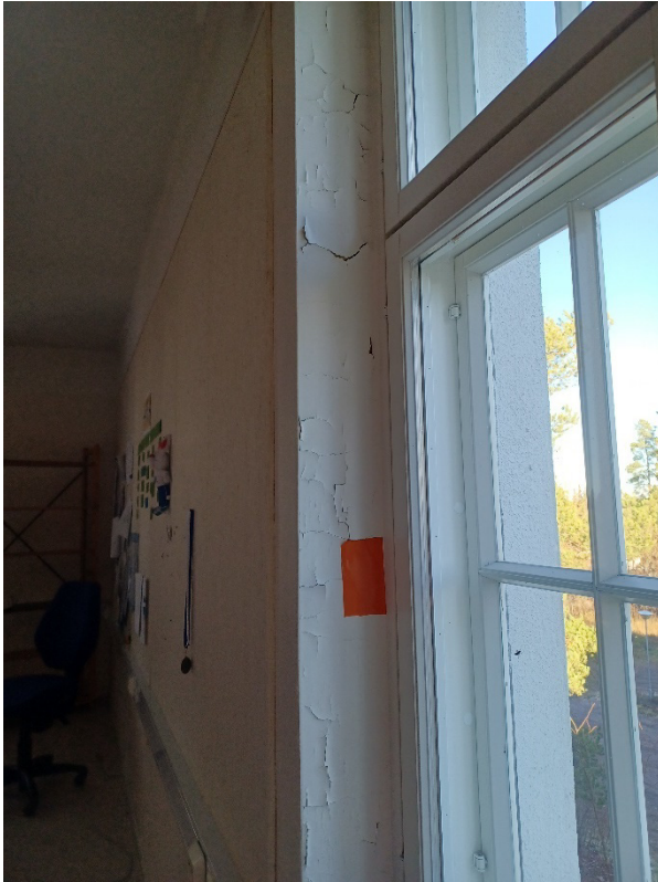
Kuva 63 Toisen kerroksen sisäikkunoita. Ikkunanpielen maalipinta on rapistunut todennäköisesti liiallisen kosteudenvaihtelun vuoksi.
