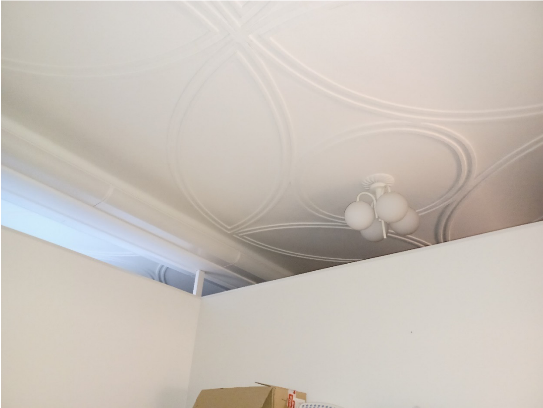
Kuva 47 Katon koristemuodot ovat edelleen jäljellä, mutta itse valtuustosali on jaettu useaan pienempään tilaan. Kattokuviot ovat todennäköisesti olleet moniväriset. Valaisimet eivät ole alkuperäiset.
