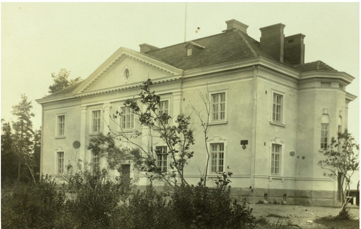
Kuva 29 Loimaan kunnantalo vuonna 1929. Kuvan oikeassa reunassa näkyy myöhemmin purettu tallirakennus. Kuva: Urho Järveläinen, lähde: Loimaan Kotiseutumuseon kokoelmat, Loimaa-Seura.
