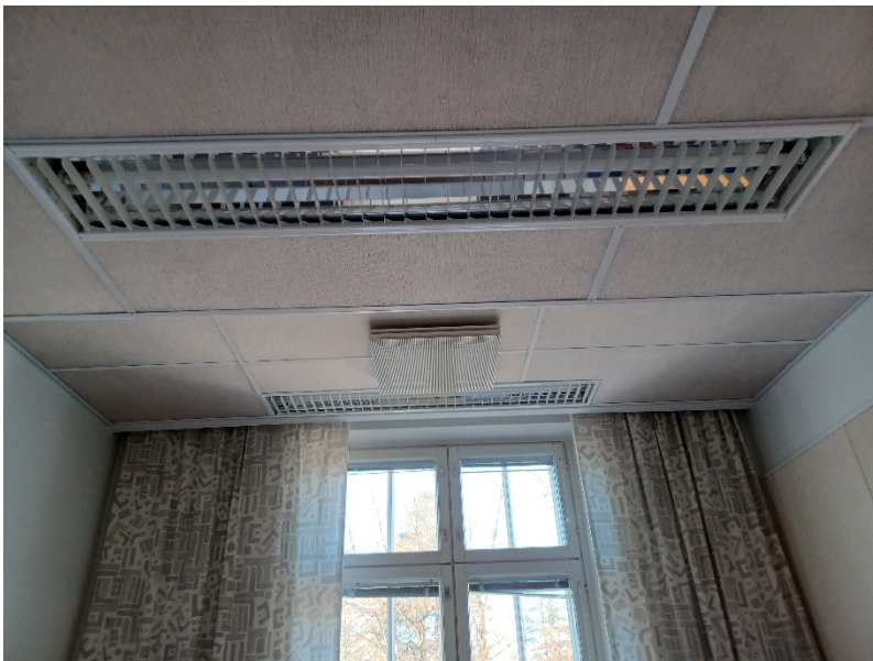
Kuva 50 Alaslasketut sisäkatot on pinnoitettu akustiikkalevyin. Loisteputkivalaisimet on upotettu kattoon.
