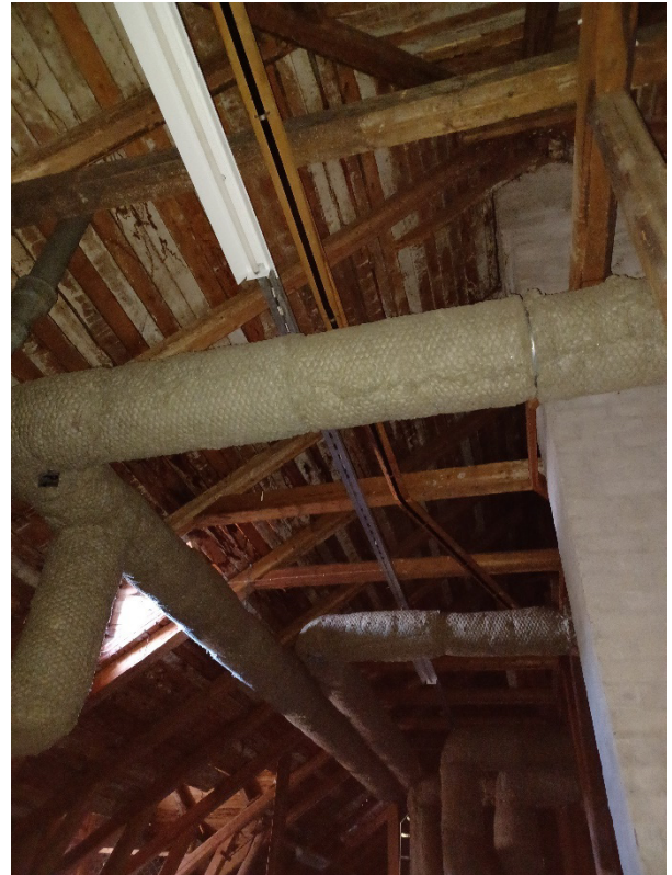
Kuva 64 Ullakko on eristämätöntä, avointa tilaa, jossa vanhat kattorakenteet ja uudemman aikaiset ilmaputkistot ovat vapaasti näkyvissä.
