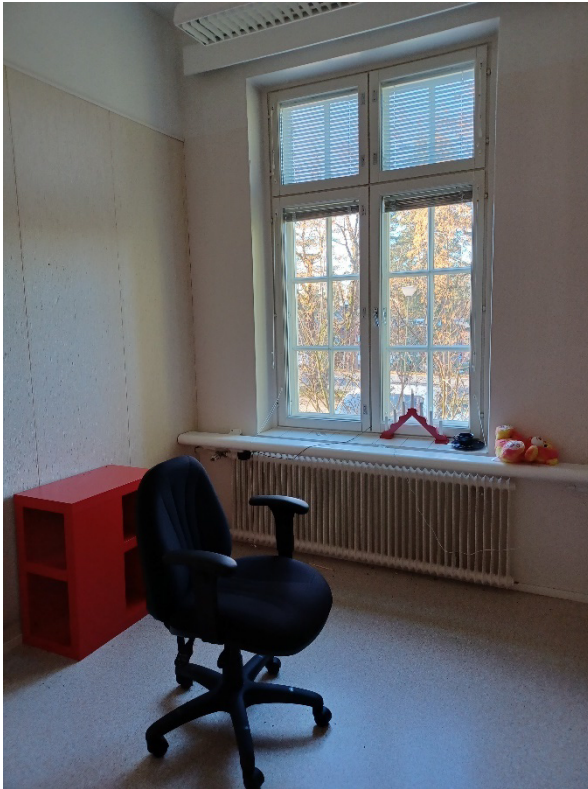
Kuva 45 Toimistohuoneet ovat hyvin saman näköisiä keskenään. Lattioita peittää vaalea muovimatto, ja seinissä on valkoiseksi maalattu lasikuitutapetti tai kangastapetti. Valurautainen lämpöpatteri on iäkäs (arviolta 1940-luvulta tai vanhempi).
