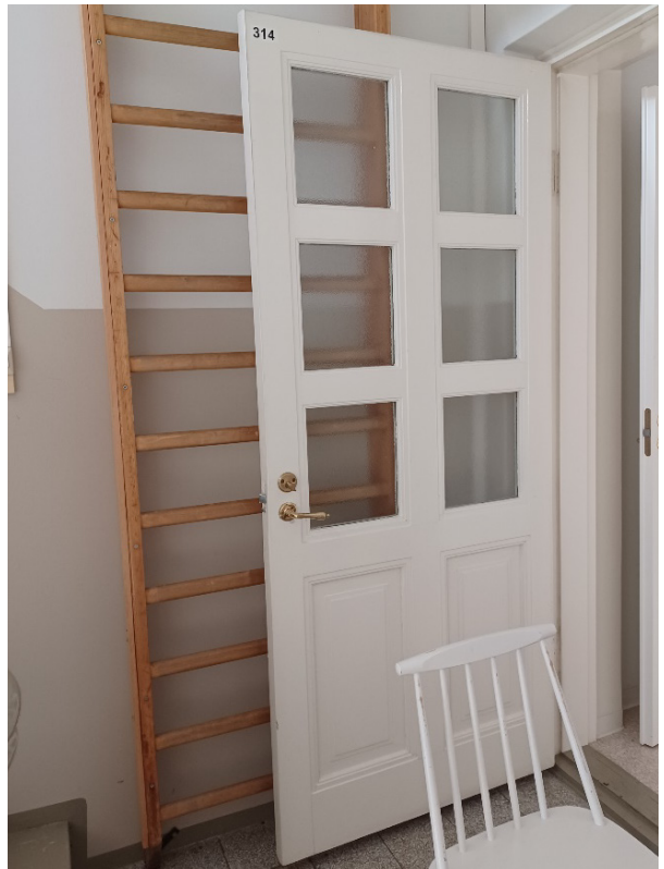
Kuva 53 Väliovet ovat enimmäkseen tehdasvalmisteisia, puristelevystä valmistettuja valsepeiliovia. Alkuperäisiä väliovia on jäljellä vain pari, ja niiden lukot ja kädensijat on vaihdettu uudenaikaisiin. Kuvassa vasemman puoleinen ovi on uusi, ja oikean puoleinen on uudistettu, mutta alkuperäinen.
