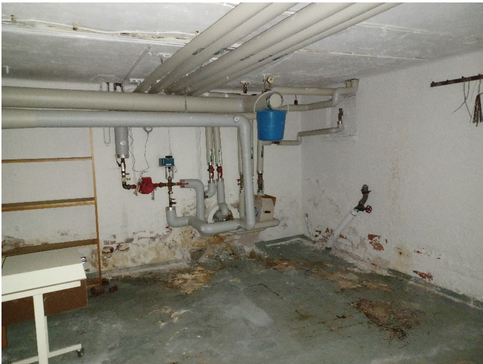
Kuva 57 Entinen pannuhuone. Rakennuksen vesiputket on uusittu.
