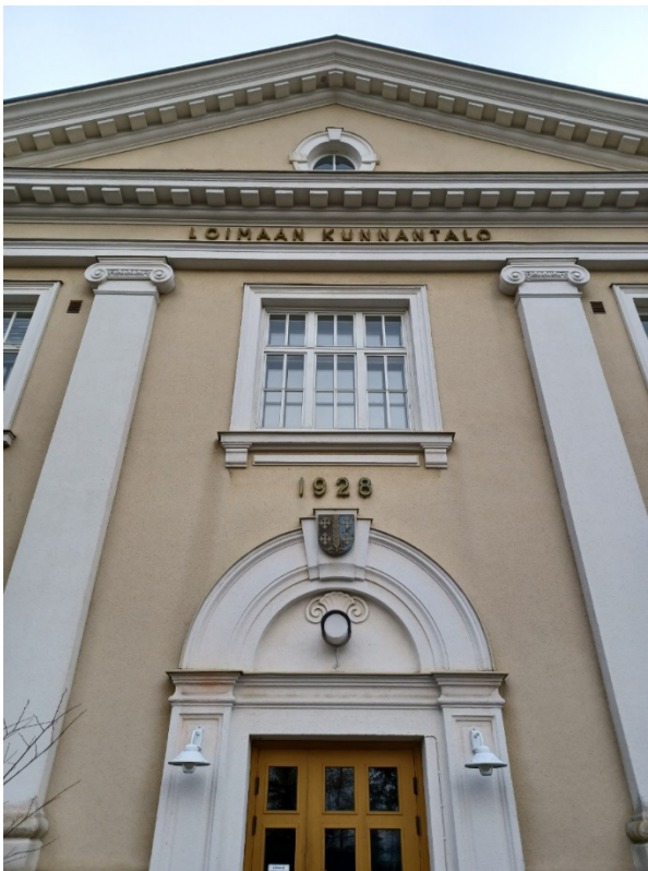
Kuva 41 Sisäänkäynti on kehystetty kaaren muotoisella koristeaiheella, jonka yläosassa on yksinkertainen valaisin sekä vaakuna. Sivuilla olevat valaisimet eivät ole alkuperäiset, vaan ne on lisätty myöhemmin.
