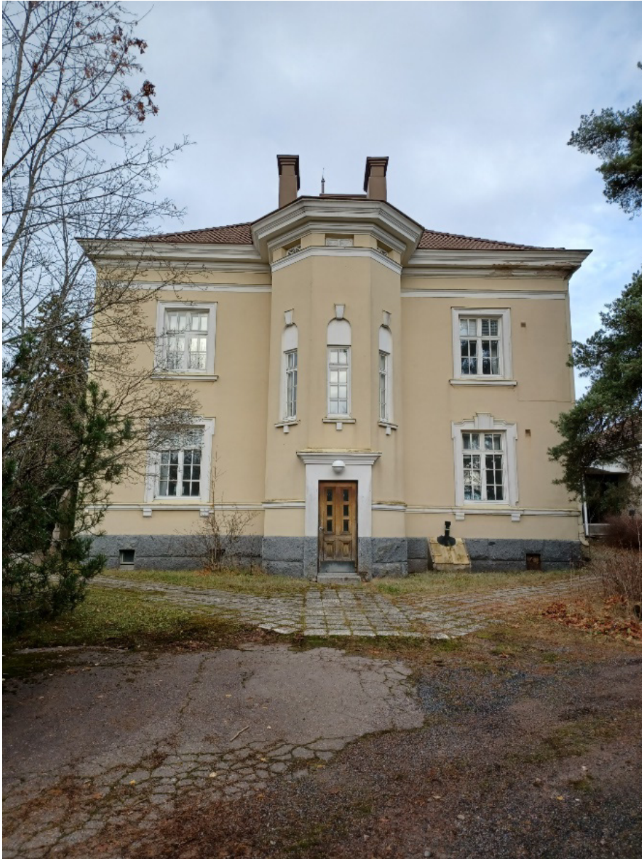
Kuva 37 Rakennuksen ympärille on laatoitettu kulkuväylää betonilaa- toin. Pihalaatoitus ei ole alkuperäinen.
