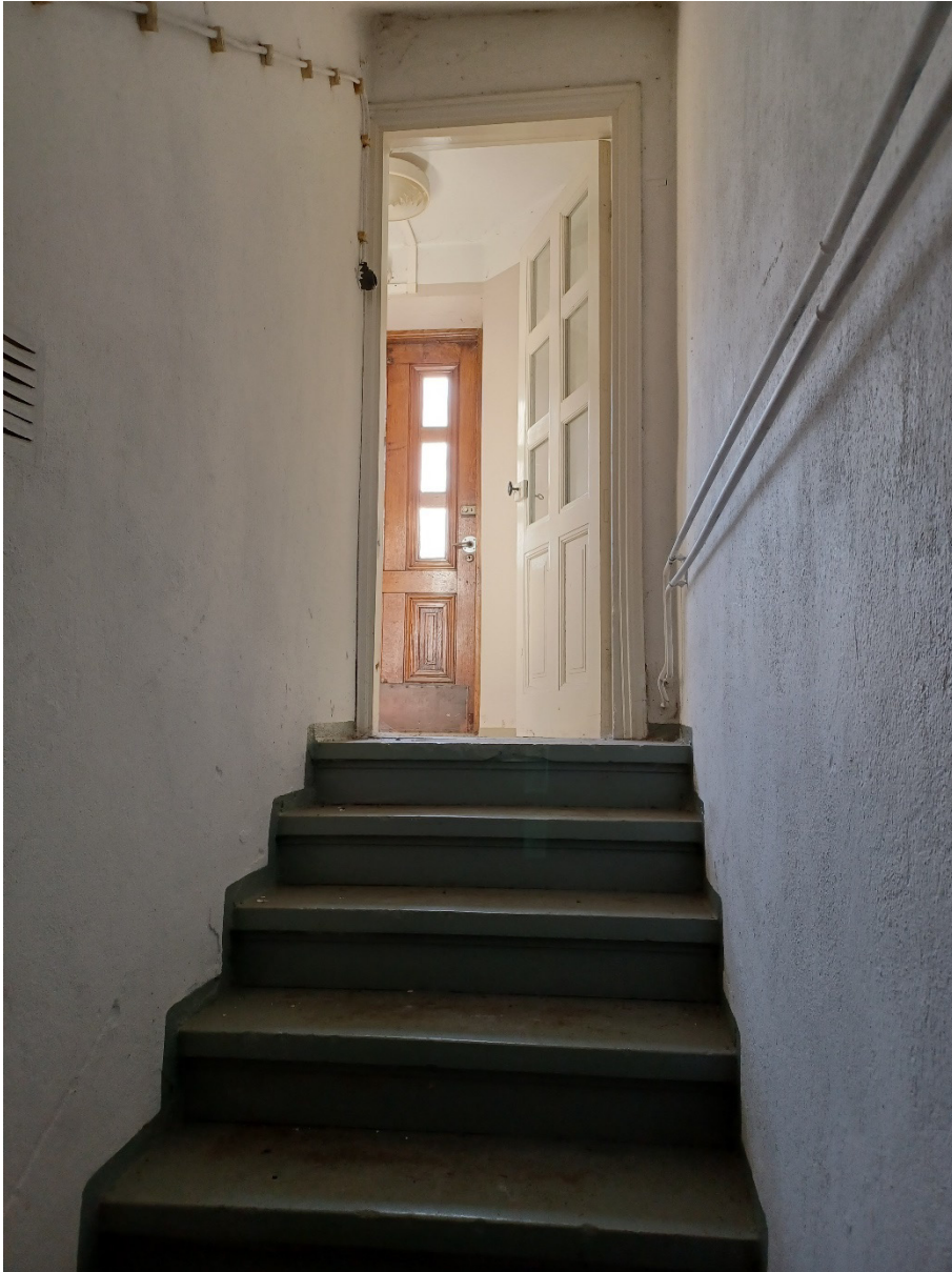
Kuva 55 Kellariin johtava portaikko on alkuperäisessä asussaan. Betoniportaat ja seinät on uudelleenmaalattu.
