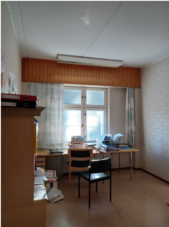
Kuva 89 Toimistuhuoneet ovat toistensa kaltaisia. Seinät ovat vaaleaksi maalattua tiiltä. Katot ovat roiskerapatut. Lattioissa on vaaleat muovimatot. Valaisimet ovat loisteputkivalaisimia. Ikkunan yläpuolella on yksityiskohtana mäntypanelointi. Osassa toimistotiloista on kulku viereiseen huoneeseen.
