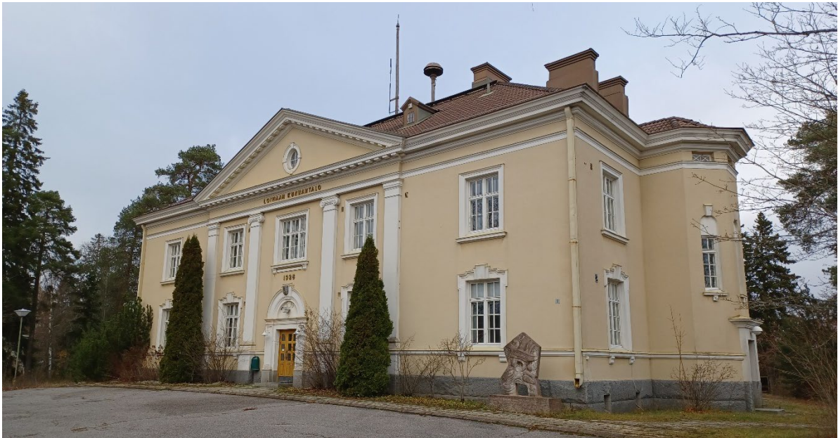
Kuva 5. Hirvikosken entinen kunnantalo on ennestään asemakaavalla suojeltu ja maakunnallisesti arvokkaaksi luokiteltu kohde. Kohteesta on laadittu erillinen rakennushistoriallinen selvitys asemakaavaprosessin aikana.
