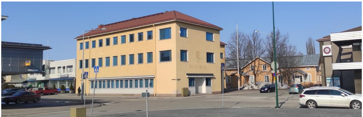
Kuva 5 - Kuva Keskustorilta kohti käytöstä poistettua kaupungintaloa 23.3.2022
