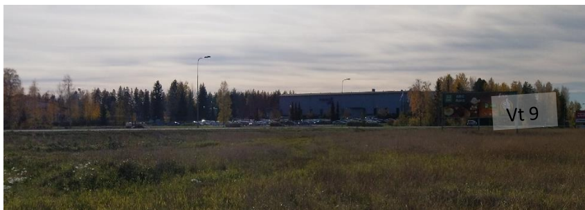
Kuva 11 - Suunnittelualueesta etelään/lounaaseen sijaitseva Pemamek Oy, kuva 10/2020
