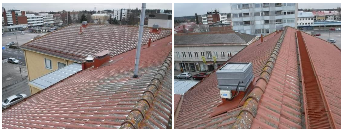
Kuvat 46 ja 47. Yleiskuvia vesikatosta.
