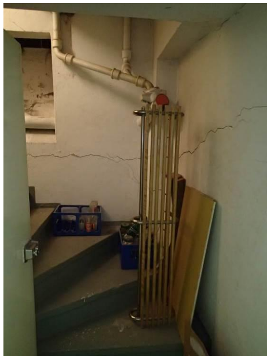
Kuvat 43 ja 44. Itäkulmassa olevan portaikon maanvastaisissa seinissä on halkeamia. Ulkopuolelta suljetun aukon alapuolella todettiin kohonneita kosteuskokkeuksia pintakosteusilmaisimella.
