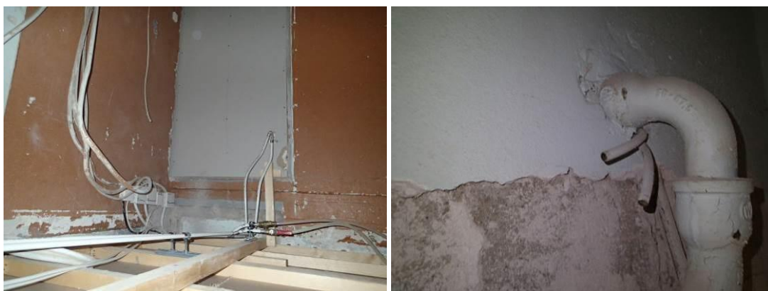
Kuvat 78 ja 79. Kellarikerroksen käytävän alakaton yläpuolella on korkea tyhjä tila, jossa on mm. vanhoja sekä uusittuja vesi- ja viemäriputkia.
