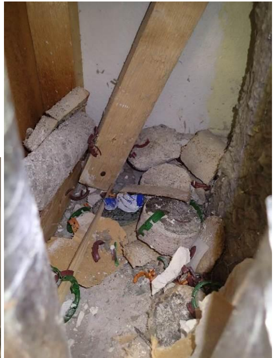
Kuvat 119 ja 120. Toisen kerroksen odotustilan 218 kohdalle tehdyssä koteloinnin avauksessa havaittiin rakennusjätettä koteloinnin sisällä.
