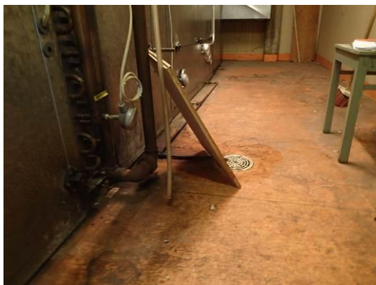
Kuvat 64 ja 65. Ilmanvaihtokonehuoneen muovimaton saumat eivät ole tiiviitä.
