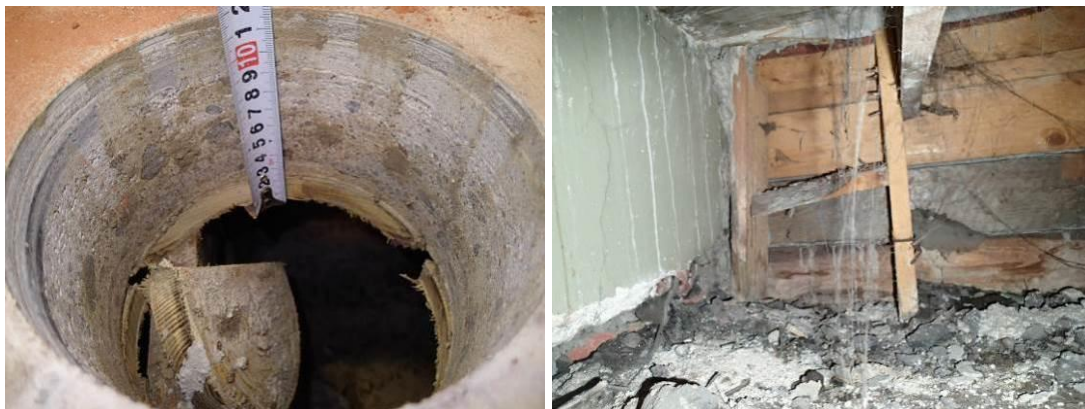
Kuvat 94 ja 95. Rakenneavaus R17 tilan 214 välipohjaan.
