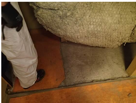
Kuvat 62 ja 63. Ilmanvaihtokonehuoneen lattiaa ei ole päällystetty koko huoneen alalta ja läpivientien kohdilta puuttuu maton ylösnostot.
