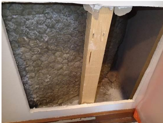
Kuvat 121 ja 122. Kolmannen kerroksen aulan koteloinnin sisällä olevien välipohjan läpiviennit vaikuttivat aistinvaraisesti tiiviltä.
