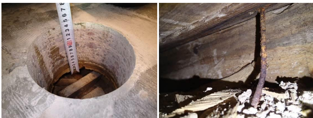
Kuvat 98 ja 99. Rakenneavaus R23 tilan 316 välipohjaan.
