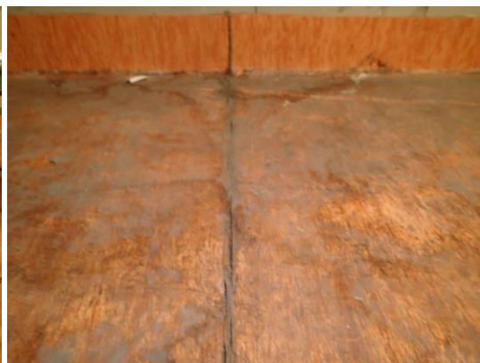
Kuvat 64 ja 65. Ilmanvaihtokonehuoneen muovimaton saumat eivät ole tiiviitä.
