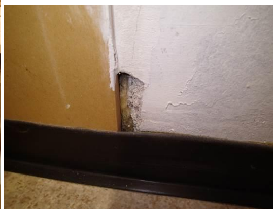
Kuvat 104 ja 105. Arkistotilassa 110 kipsilevyn ja pilarin liittymien raoissa havaittiin mineraalivillaaeristettä ja liittymien kautta todettiin ilmavuotoa huonetilojen välillä.
