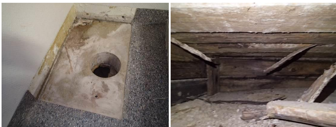
Kuvat 96 ja 97. Rakenneavaus R20 tilan 322 välipohjaan.
