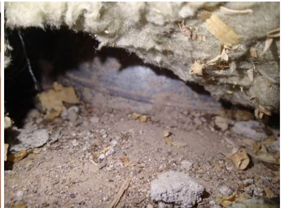
Kuvat 121 ja 122. Kolmannen kerroksen aulan koteloinnin sisällä olevien välipohjan läpiviennit vaikuttivat aistinvaraisesti tiiviltä.
