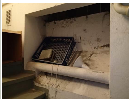
Kuvat 43 ja 44. Itäkulmassa olevan portaikon maanvastaisissa seinissä on halkeamia. Ulkopuolelta suljetun aukon alapuolella todettiin kohonneita kosteuskokkeuksia pintakosteusilmaisimella.
