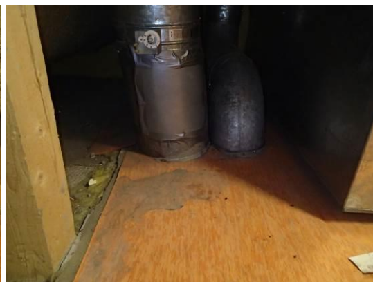
Kuvat 62 ja 63. Ilmanvaihtokonehuoneen lattiaa ei ole päällystetty koko huoneen alalta ja läpivientien kohdilta puuttuu maton ylösnostot.
