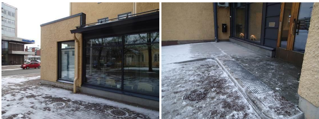
Kuvat 19 ja 20. Pääsisäänkäynnin kohdalla metallirakenteisten ikkunoiden alapuolen seinä on ns. valesokkelirakennetta.
