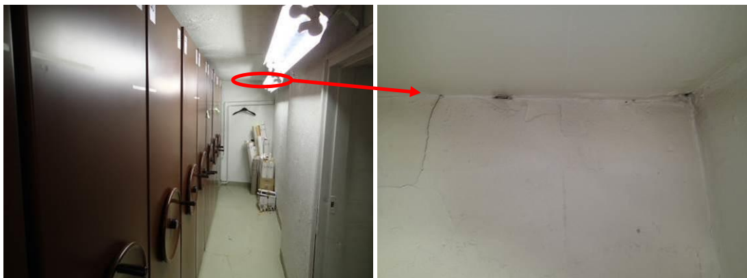
Kuvat 41 ja 42. Ilmavuotokohtia arkistotilan maanvastaisen seinän yläreunassa.
