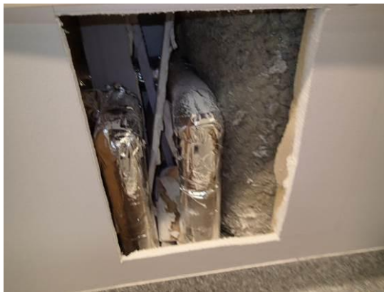
Kuvat 119 ja 120. Toisen kerroksen odotustilan 218 kohdalle tehdyssä koteloinnin avauksessa havaittiin rakennusjätettä koteloinnin sisällä.
