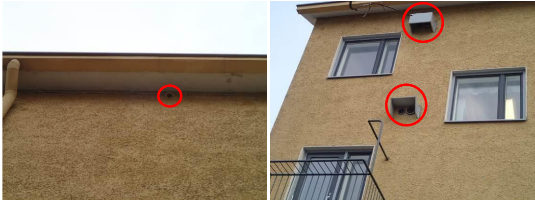
Kuvat 15 ja 16. Vasemman puoleisessa kuvassa näkyy räystäään alla ullakkotilan tuuletusputki. Oikeassa kuvassa on kellarikerroksen ilmanvaihdon seinäläpiviennit.
