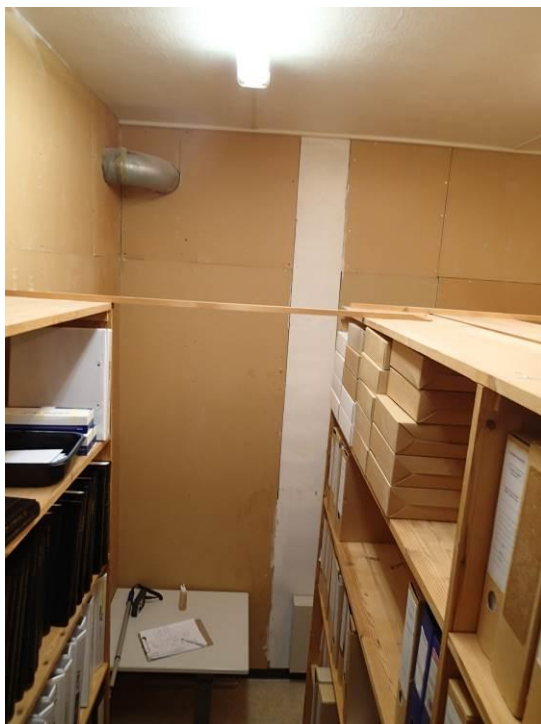
Kuvat 104 ja 105. Arkistotilassa 110 kipsilevyn ja pilarin liittymien raoissa havaittiin mineraalivillaaeristettä ja liittymien kautta todettiin ilmavuotoa huonetilojen välillä.
