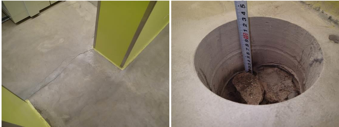
Kuvat 5 ja 6. Arkistotilan lattiasta poratusta betonilieriössä aistittiin voimakas öljyn haju. Öljyn hajua aistittiin myös alapohjan täyttöhiekassa.
