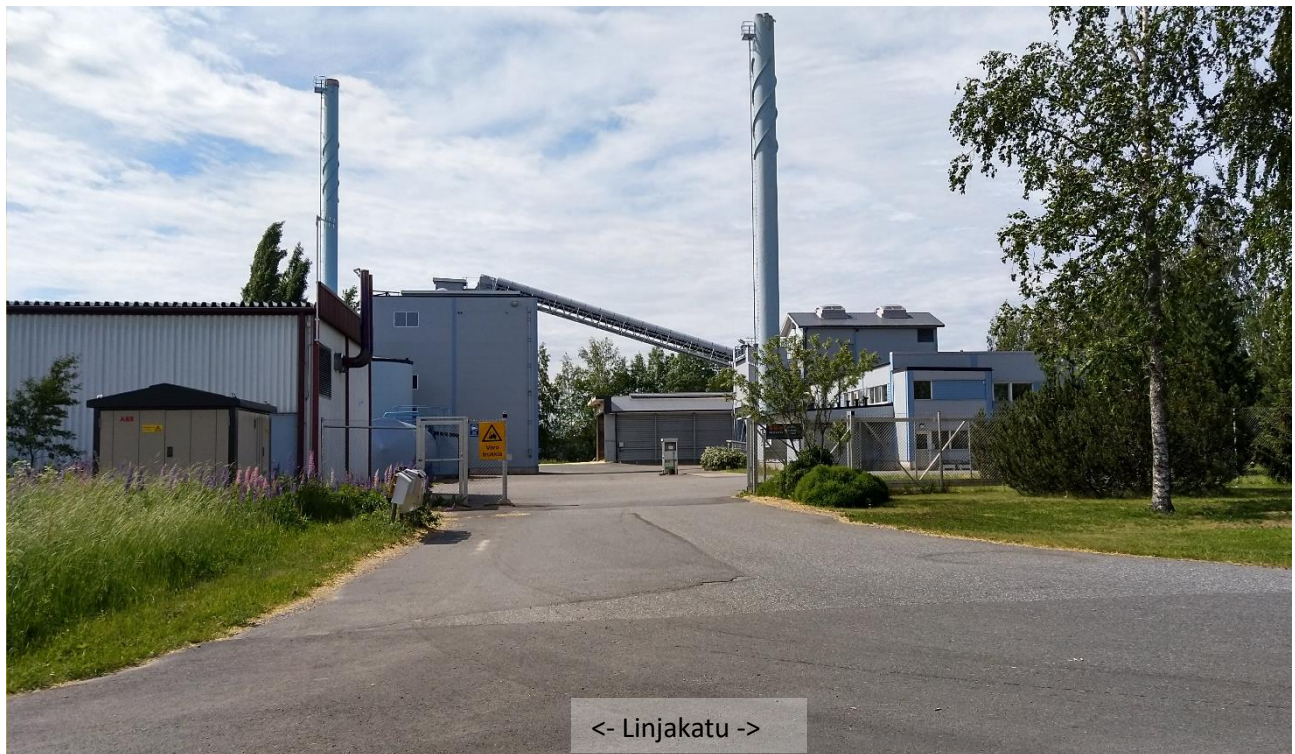
Kuva 8 - Näkymä Kaukolämpölaitoksen suuntaan 12.6.2019
