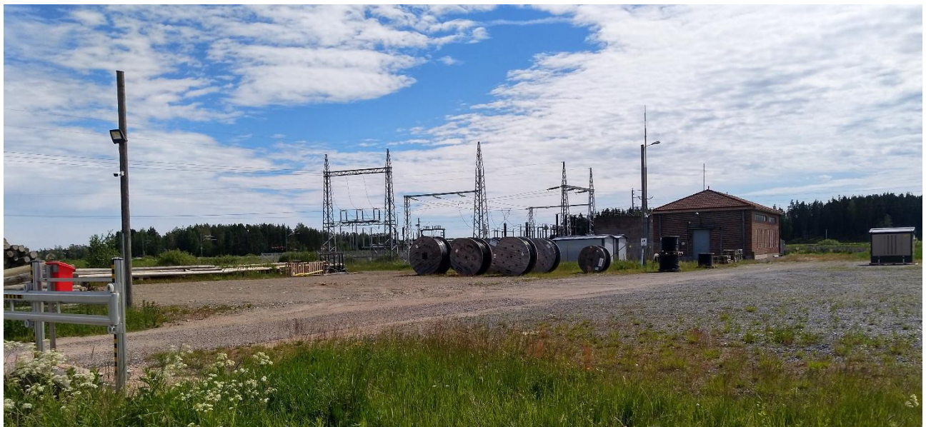
Kuva 11 - Näkymä Volttikadun päästä itään sähkönsyöttö- ja sähkömuuntamoiden alueelle (rautatien ja sähkölaitoksen toimintoja) 12.6.2019
