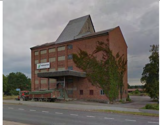
kuvaote Google Street View – elokuu 2011: myllyrakennuksen julkisivu maantielle (Hämeentie, mt 213)
