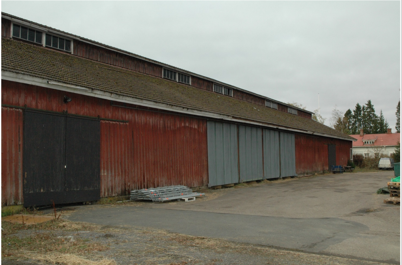
kuva: Makasiinin itäjulkisivua.
